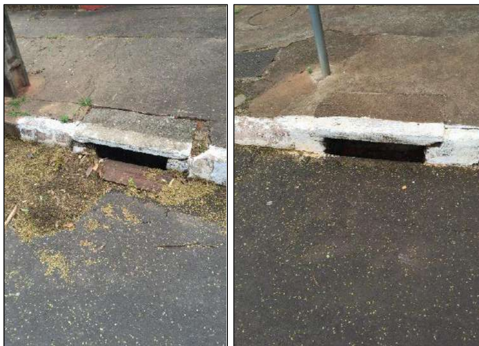
Figura 35 – Drenagem Urbana. Fonte: Autor.
