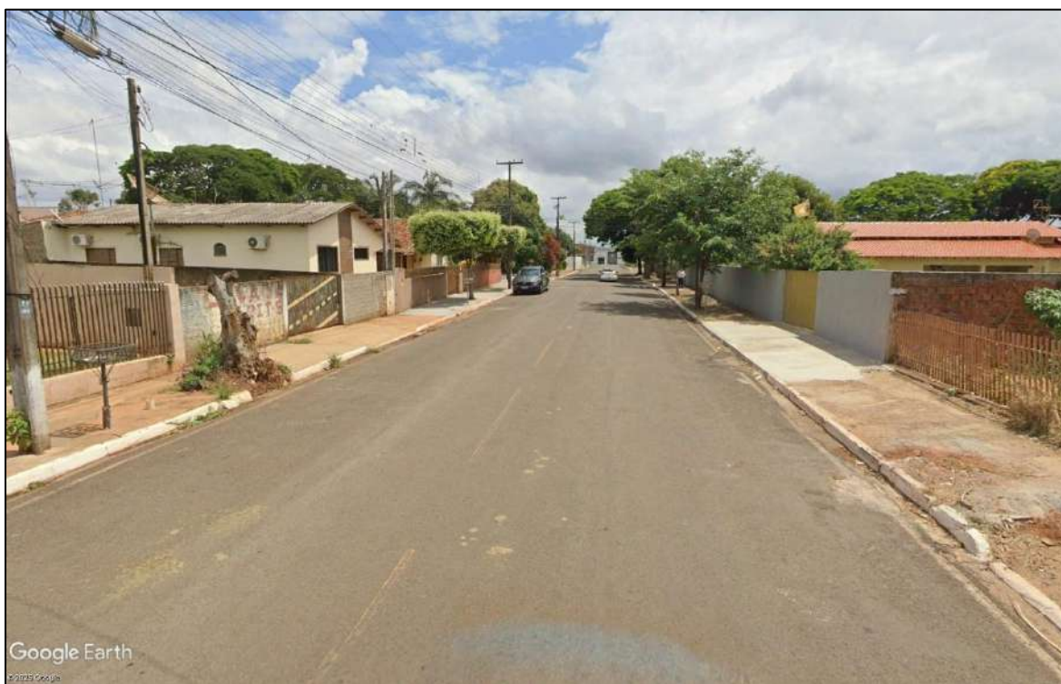
Figura 30 – Limpeza e conservação de vias públicas e praças municipais. Fonte: Google Earth
